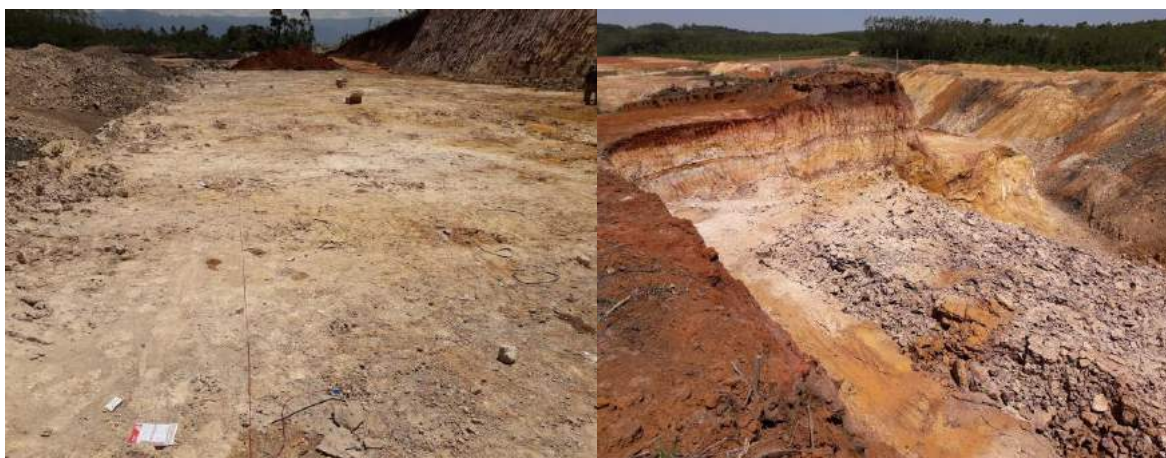
Figura 3: Situação da bancada a esquerda, antes do desmonte, e a direita após a detonação.
